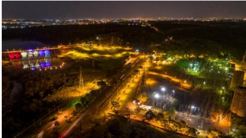
Figura 12: Sistema de iluminación de la central hidroeléctrica Acaray.
