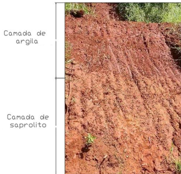
Figura 17 – Camadas de solo observadas no talude
