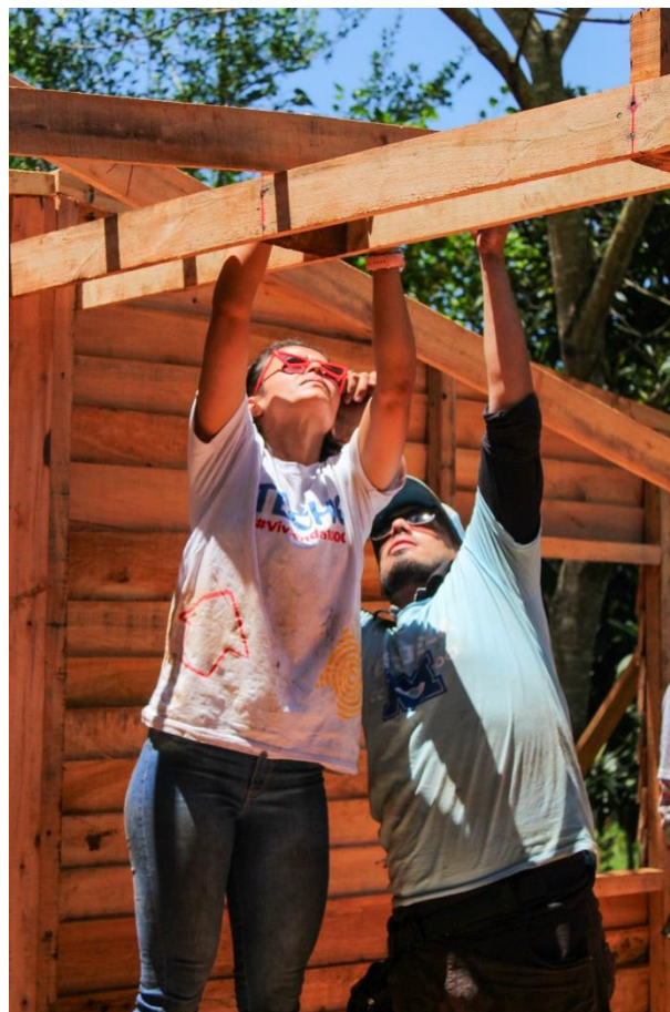
Ilustración 19. Colocacion de viga secundaria
