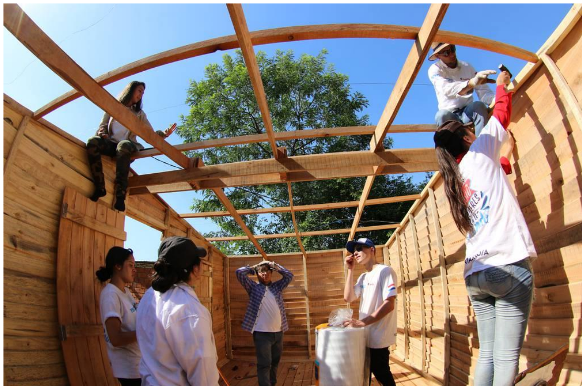
Ilustración 37. Instalación de las Vigas Costaneras
