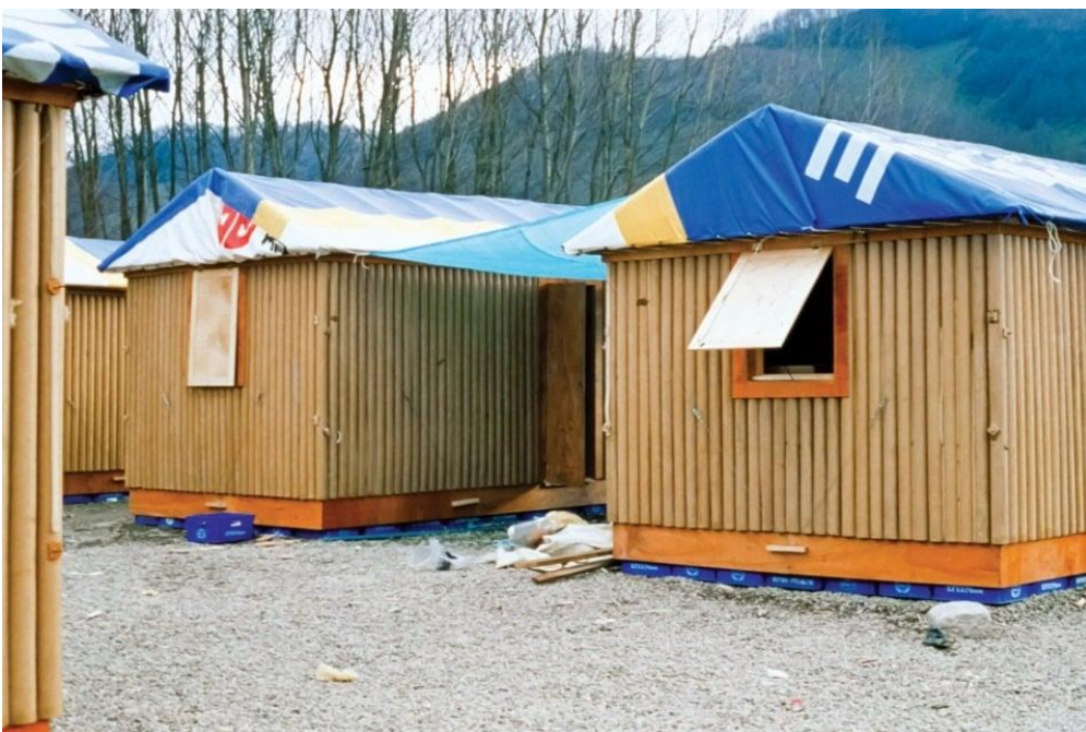
Ilustración 13. Viviendas de emergencias construidas.
