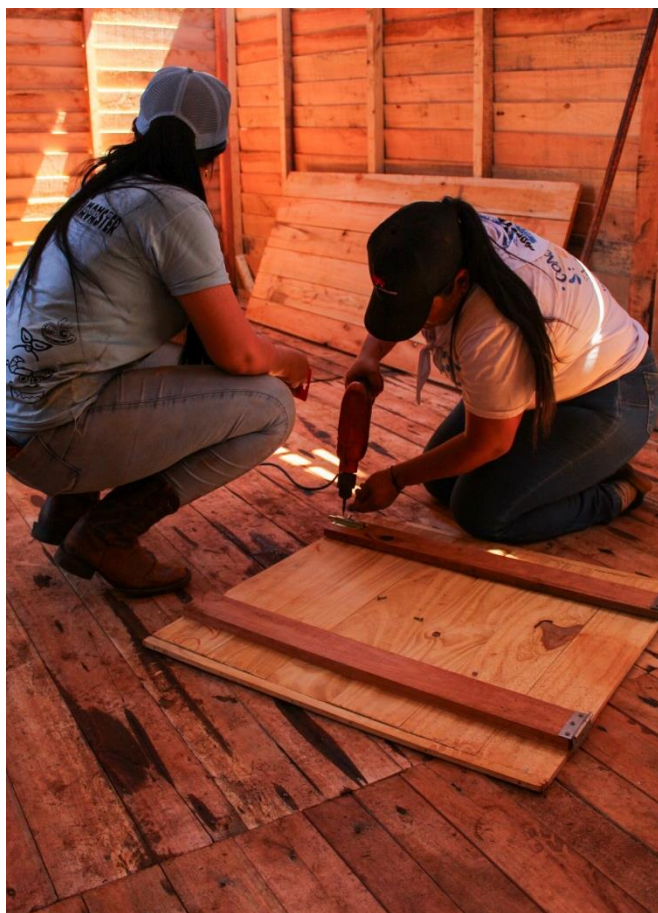
Ilustración 20. Instalacion de visagras de ventana
