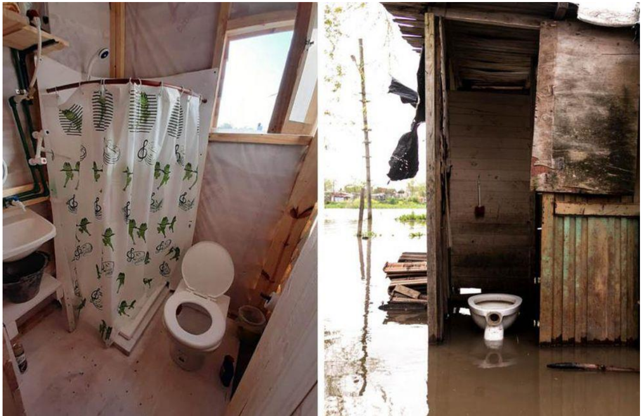
Ilustración 35. Imagenes del antes y despues de la instalacion del Modulo Sanitario
