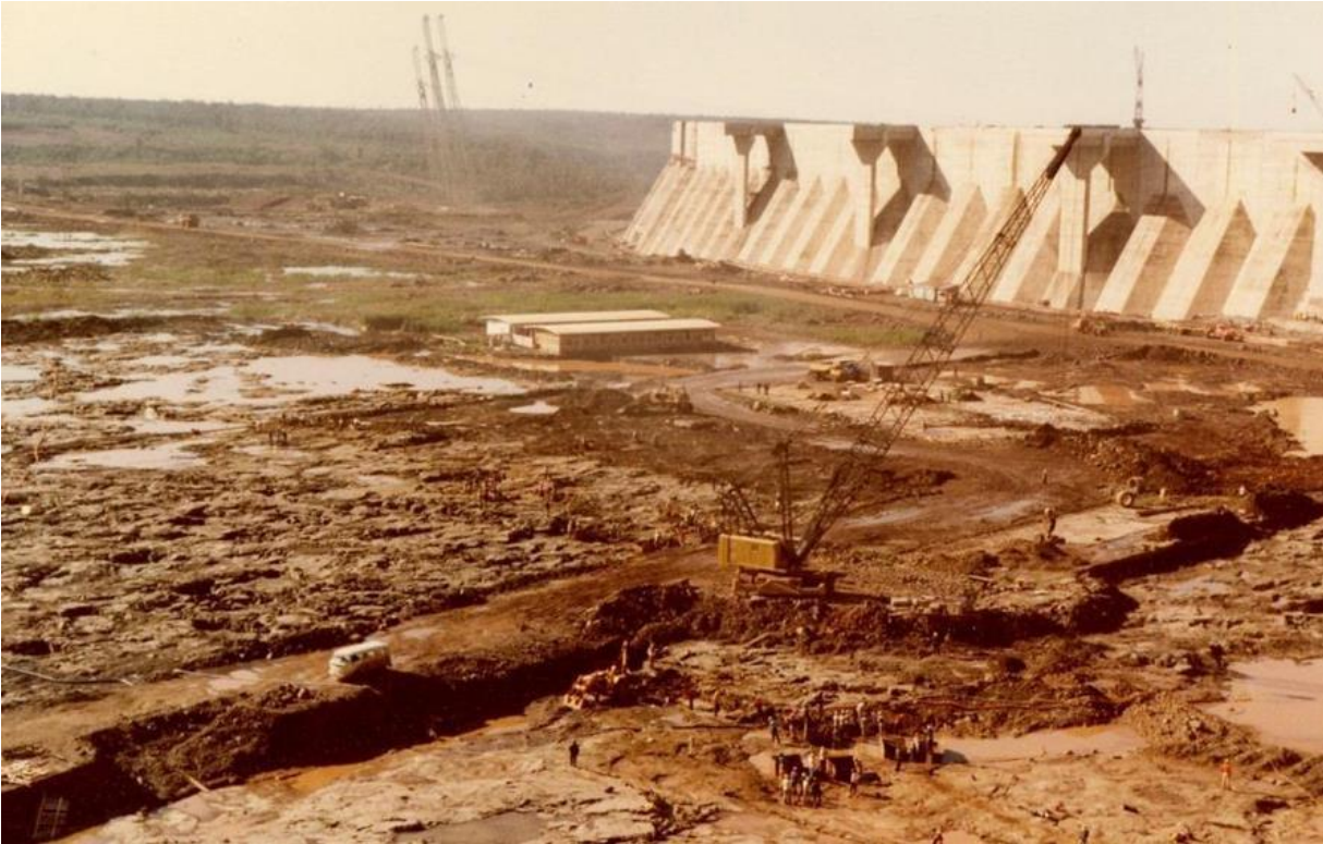
Fotografia 6: transformando o território, a construção da UHE de Itaipu.
