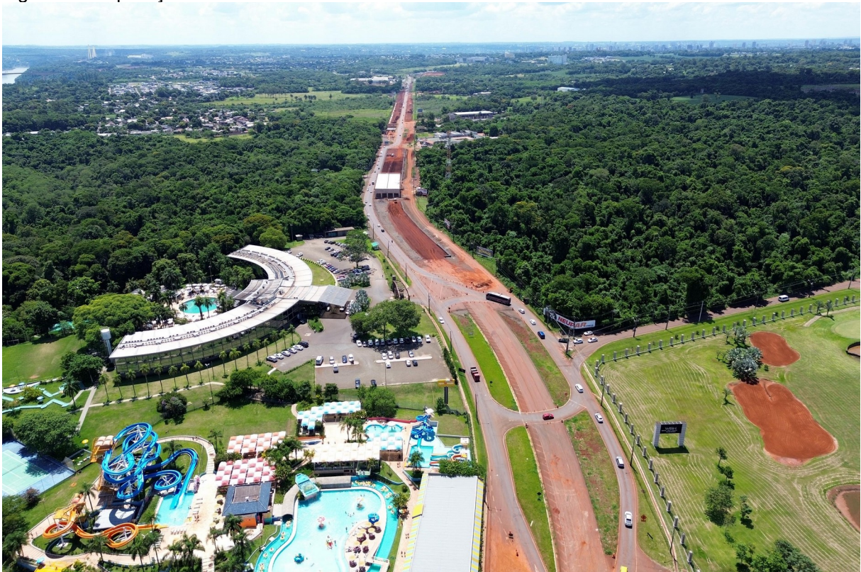
Figura 10: Duplicação da Rodovia das Cataratas - BR-469/PR
