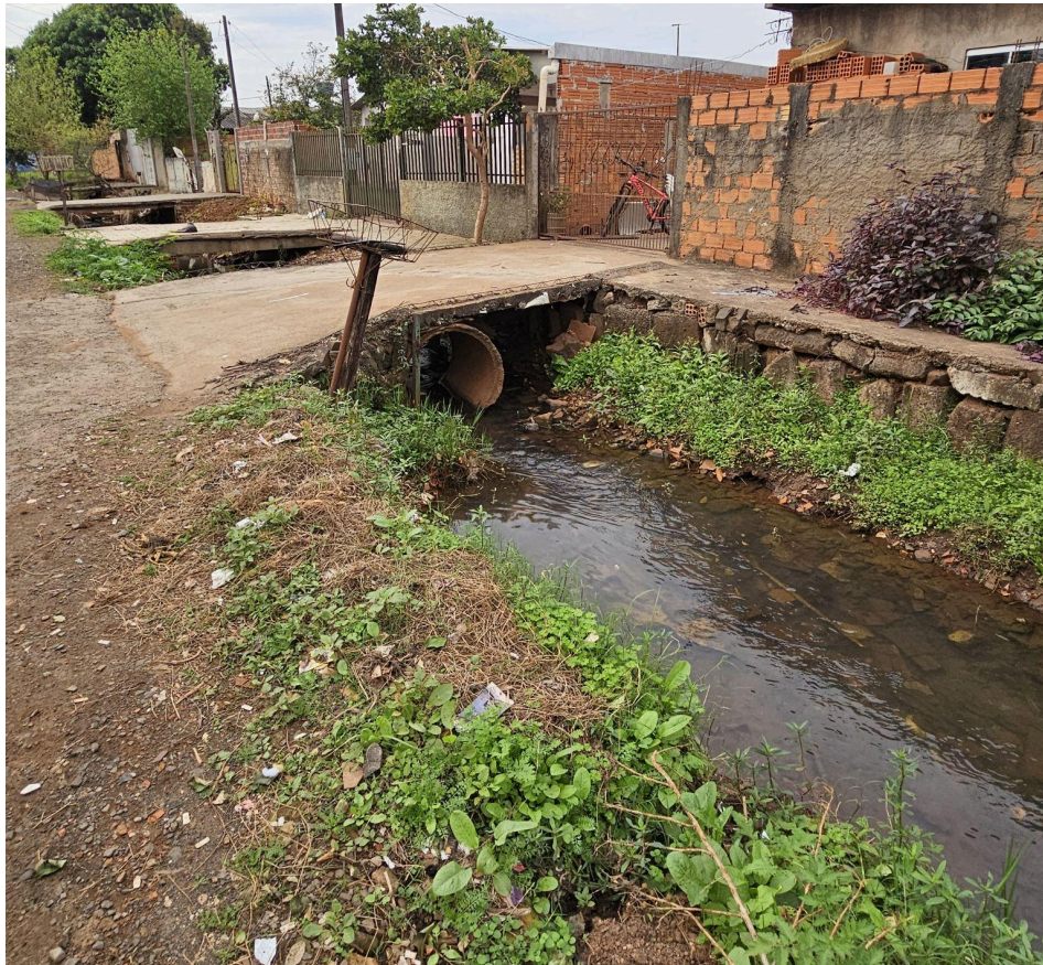
Figura 32 - Fotografia do córrego da Rua Flávio Cavalieri.
