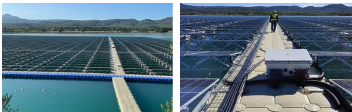
Figura 17 - Disposición de los módulos y del inversor sobre la estructura flotante. (Fuente: F2B Fotovoltaico Flutuante Brasil, 2025).
