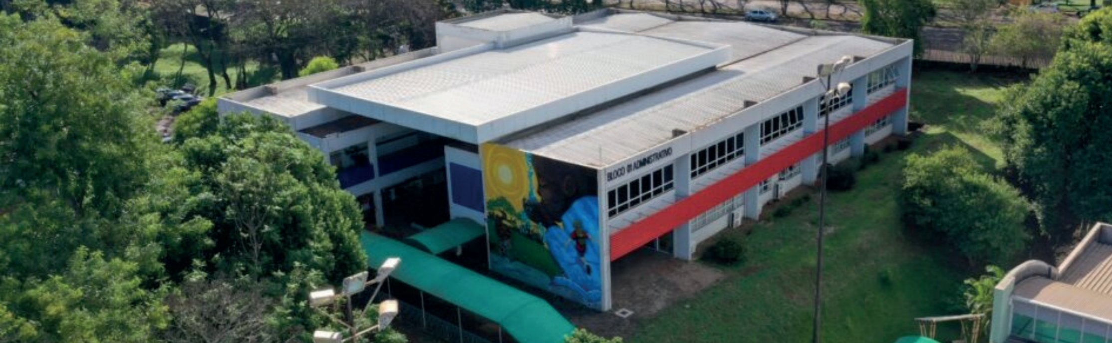
Figura 17 - Bloco Administrativo IFPR - Campus Foz do Iguaçu.
