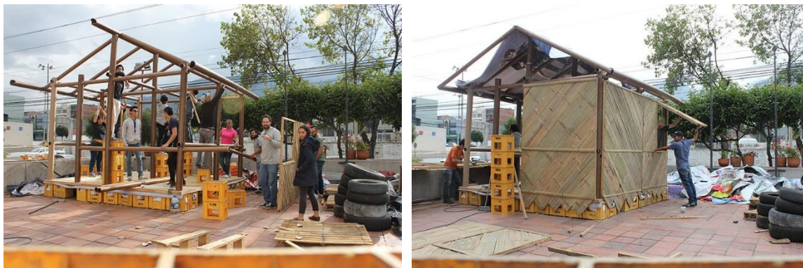
Figura 34 e 35 - Execução in loco do projeto de habitação provisória (2016)
