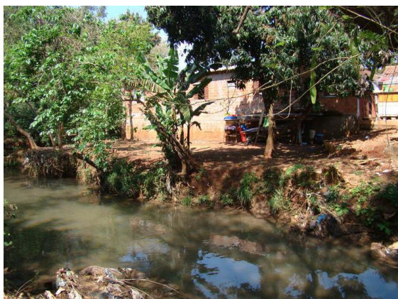
Figura 55 – Moradia de alto risco – Alameda Atuma – Foz do Iguaçu/PR
