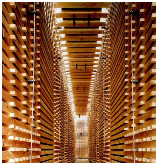
Figura 67 - Detalhe estrutural do pavilhão
