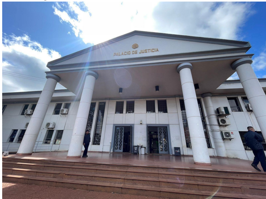
Imagen 14: Edificio del Poder Judicial de Ciudad del Este
