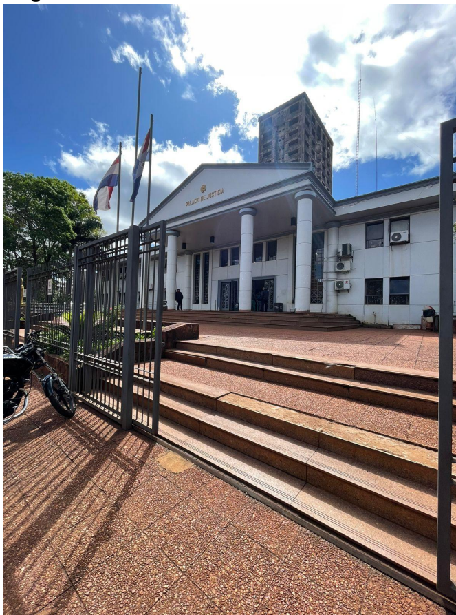
Imagen 15: Edificio del Poder Judicial de Ciudad del Este
