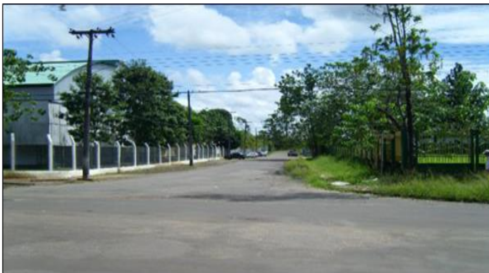
Figura 20 - Pavimentação Vila Amazonas
