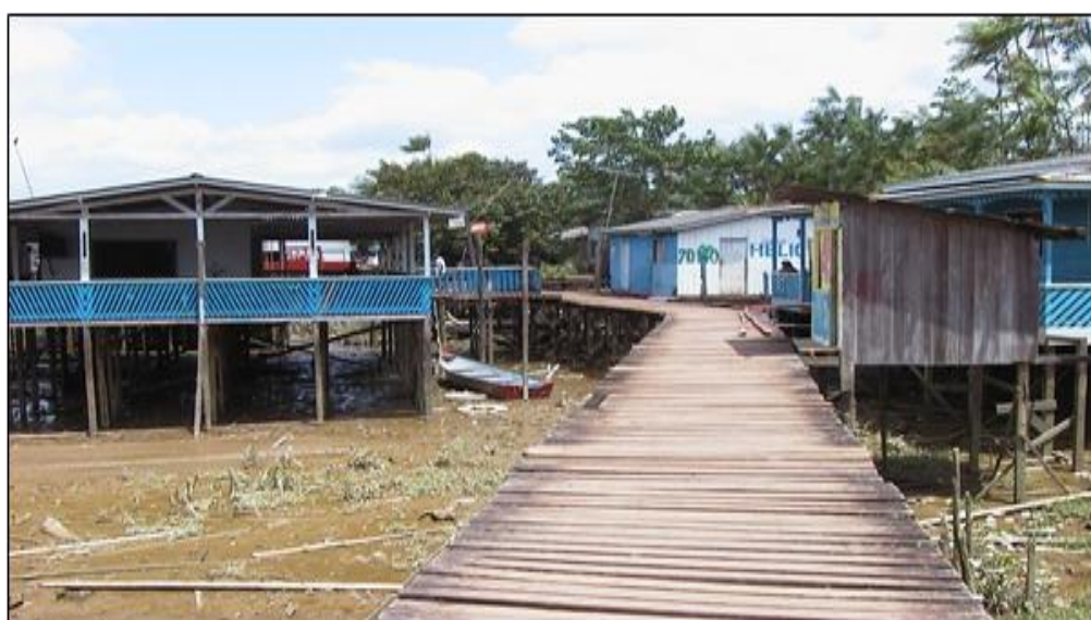
Figura 19 - Casas e passarelas da Vila do Elesbão
