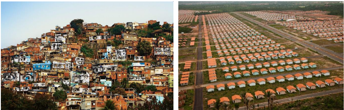
Figura 2: À esquerda, típico caso de autoconstrução - Favela do Morro da Providência, Rio de Janeiro. Fonte: Sooke, 2015. À direita, modelo usual de construção de habitação social pelo governo - Conjunto Habitacional Jacinta Andrade, Teresina-PI. Fonte: Falcão, 2011, montagem da autora, 2016.
