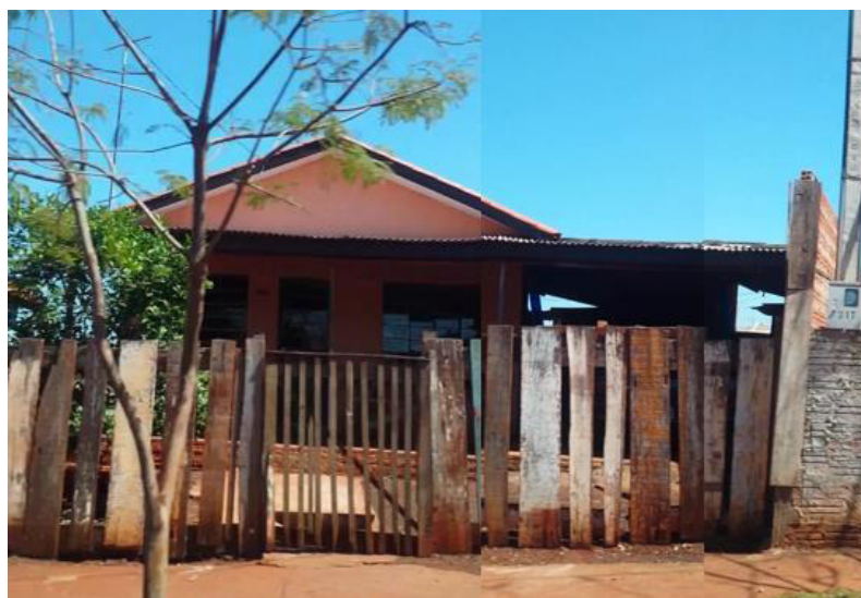
Figura 40: Ampliação frontal e lateral da cobertura em casa do Jardim Almada. Fonte: acervo e montagem da autora, 2016.
