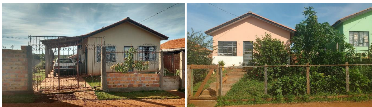
Figura 34: Construções de muros e grades para criação de divisa dos lotes. Fonte: acervo da autora, 2016.
