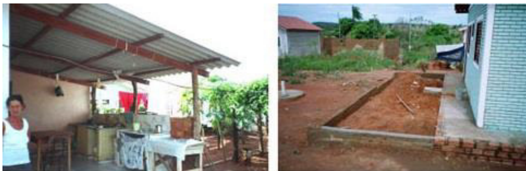
Figura 52: À esquerda, ampliação de área de serviço e lazer, e à direita, preparação de alicerce para ampliação da casa. Fonte: Brandão, 2011, montagem da autora, 2016.
