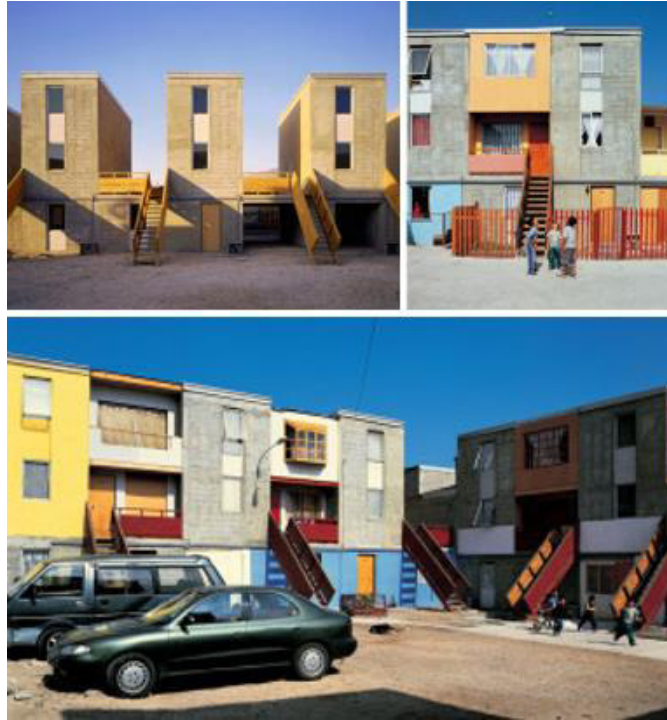
Figura 17: Imagens da estrutura das habitações entregues e depois de ocupadas e transformadas pelos moradores.
