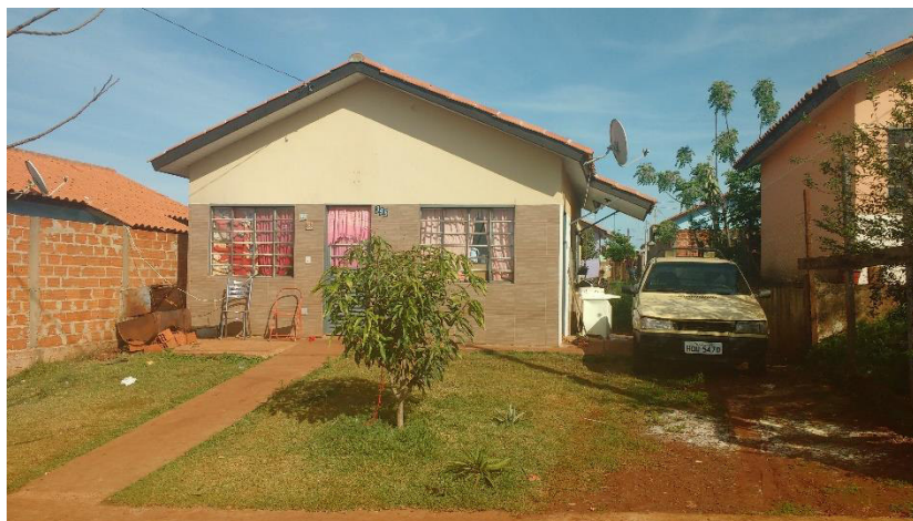
Figura 44: Aplicação de revestimento nas paredes da fachada frontal em casa do Jardim Almada. Fonte: acervo da autora, 2016.
