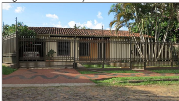
Figura 116: Edificação residencial - Área 4
