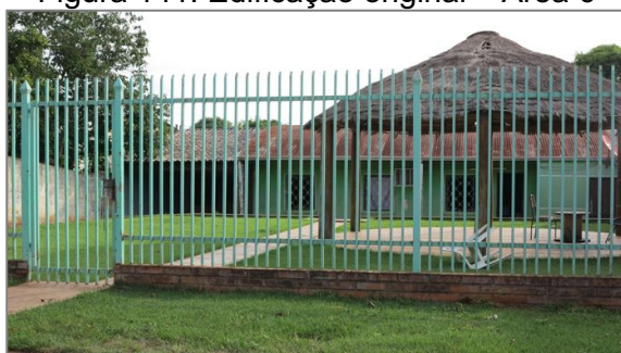
Figura 141: Edificação original – Área 6
