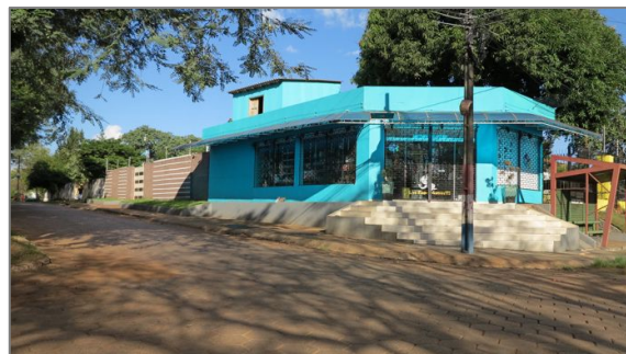
Figura 121: Edificação comercial da Área 4
