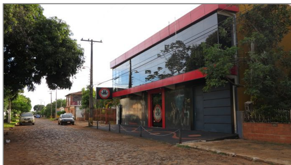
Figura 145: Edificação modificada ou substituída – Área 6
