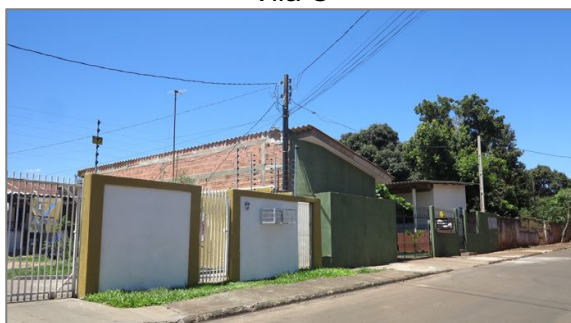
Figura 131: Construção na frente do lote - Vila C
