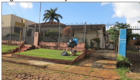
Figura 117: Edificação residencial - Área 4
