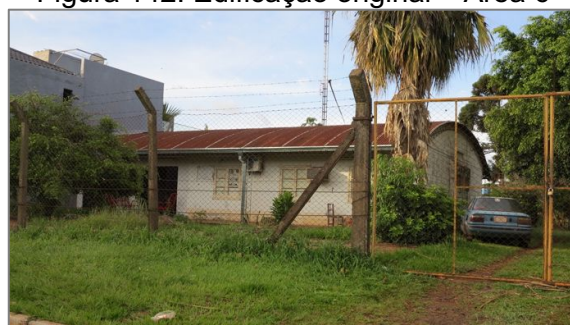
Figura 142: Edificação original – Área 6
