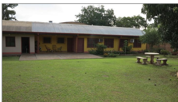
Figura 143: Edificação original – Área 6
