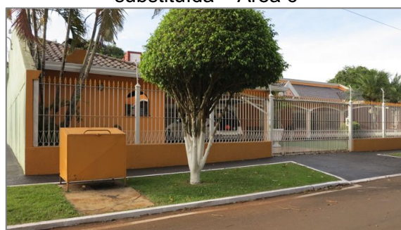
Figura 144: Edificação modificada ou substituída – Área 6
