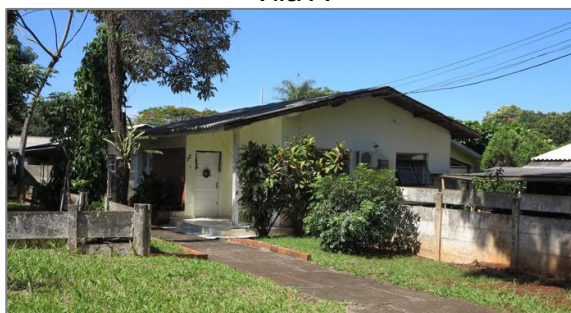
Figura 102: Casa de alvenaria inalterada - Vila A
