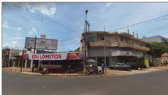
Figura 120: Edificação mista com 2 pav. na Área 4
