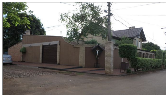
Figura 146: Edificação modificada ou substituída – Área 6
