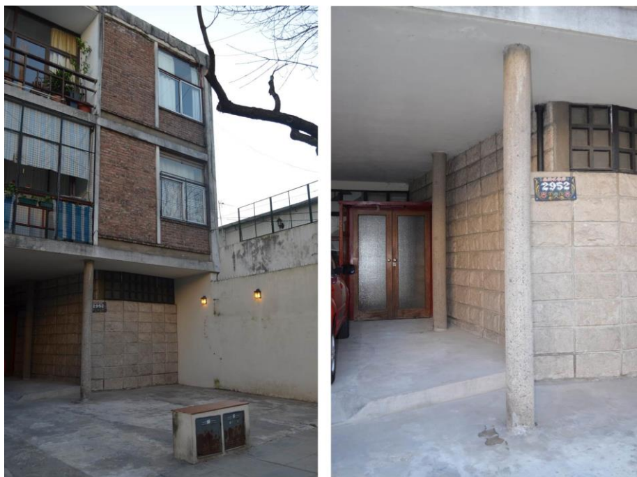
Figura 55. Destaque para a caixa de inspeção de água e luz e pilares de sustentação dos pavimentos superiores. Casa Arcos 2952, Buenos Aires, 1939.
