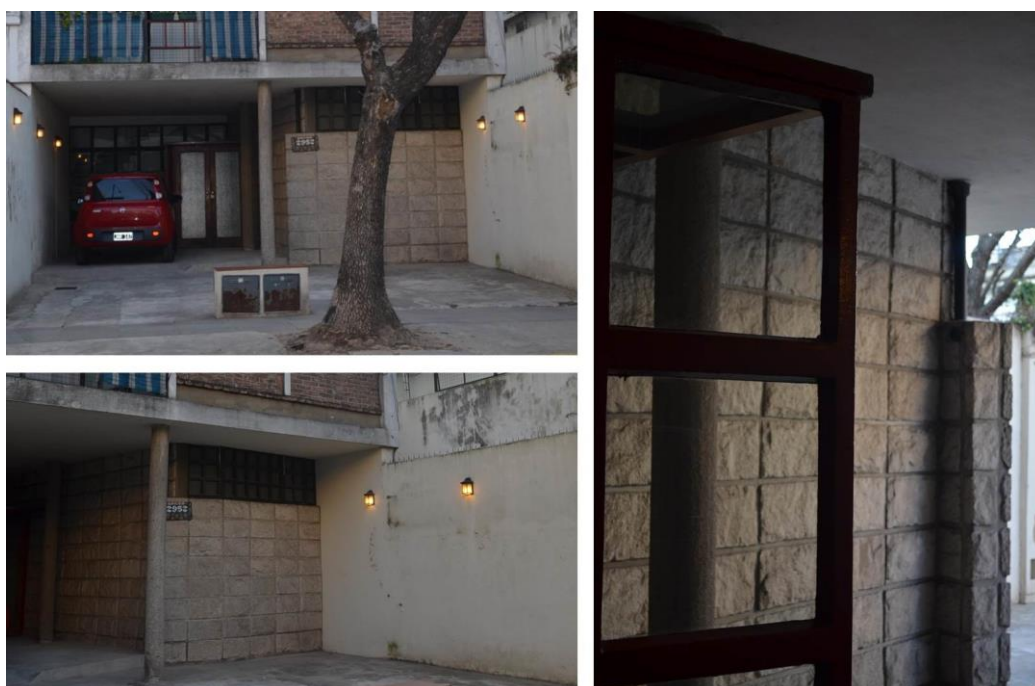
Figura 56. Detalhes da parede frontal do edifício. Casa Arcos 2952, Buenos Aires, 1938.
