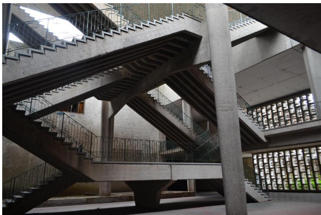
Figura 76. Escadas de circulação entre os pavimentos subterrâneos das galerias.
