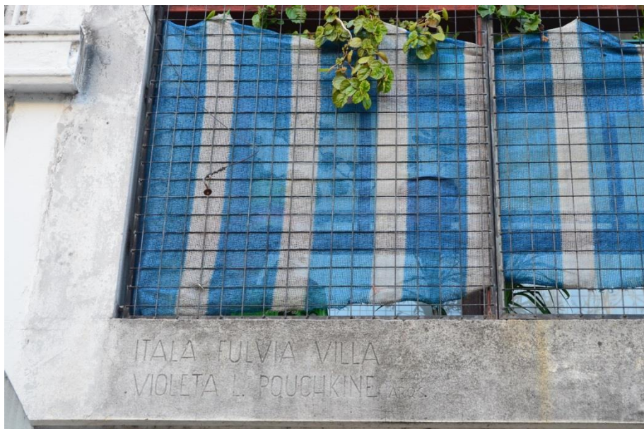
Figura 59. Detalhe dos nomes das arquitetas escritos na laje do edifício. Casa Arcos 2952, Buenos Aires, 1938.
