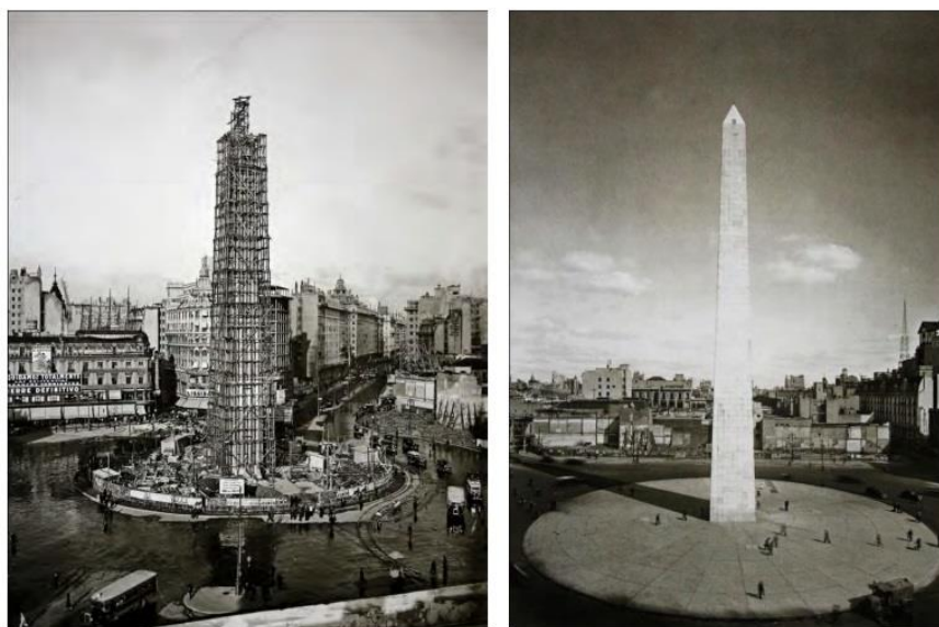
Figura 2. A construção do Obelisco, em abril de 1936, e o monumento finalizado, em 1937.
