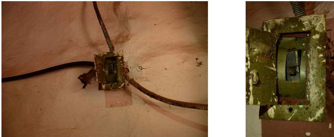
Fig. 4 Instalación eléctrica de la locación.
