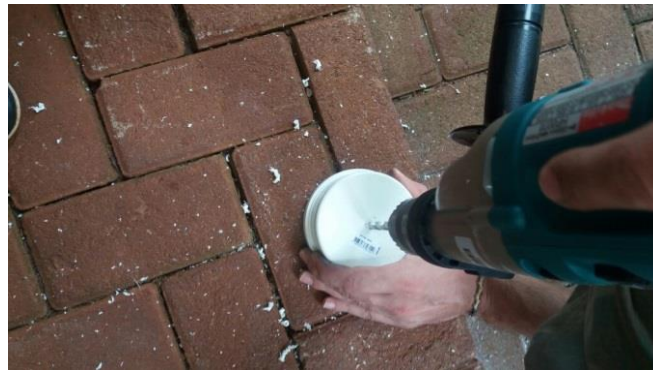
Figura 9 - Realización del agujero para introducción del inyector.
