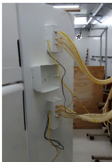
Figura 23 - Instalación del cuadro central.
