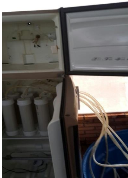
Figura 6 - Conexión de prueba del biodigestor.
