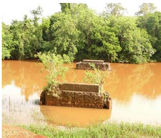
FIGURA 8 – RESQUÍCIOS DA PONTE QUEIMADA
