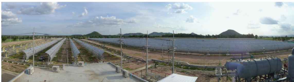
Figura 13 – Planta Solar de Kanchanaburi
