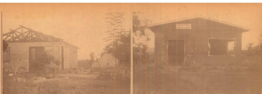
Casas em ruínas: a imagem de desolação na zona de Três Lagoas
