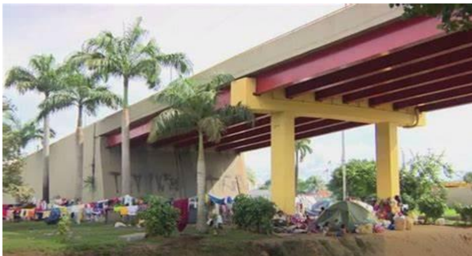
Figura 5 - Viaduto de Manaus
