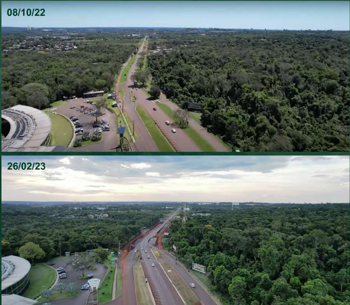
Figura 28 - Vista aérea del viaducto del km 2+200
