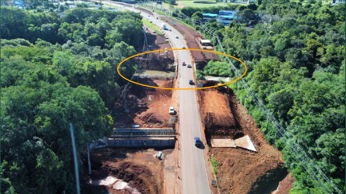
Figura 60 - Enrocamento (defensa) en la ribera del río Tamandúá (21/03/23)
