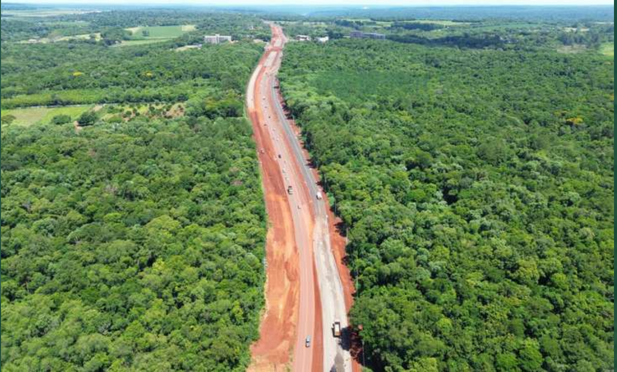
Figura 49 - Vista aérea del Viaducto del km 3,9 en sentido PNI (11/01/24).
