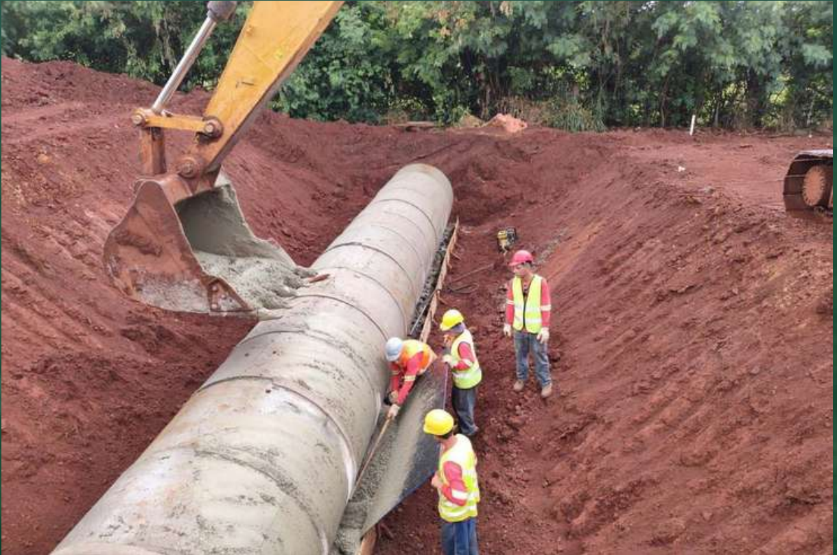
Figura 41 - Colocando colector ( manilha ) de Aguas Pluviales (18/01/2023)
