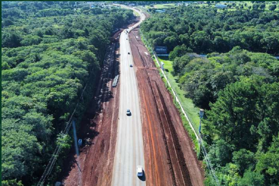
Figura 44 - Área de construcción del paso de fauna del km 2,9 (22/03/2023)
