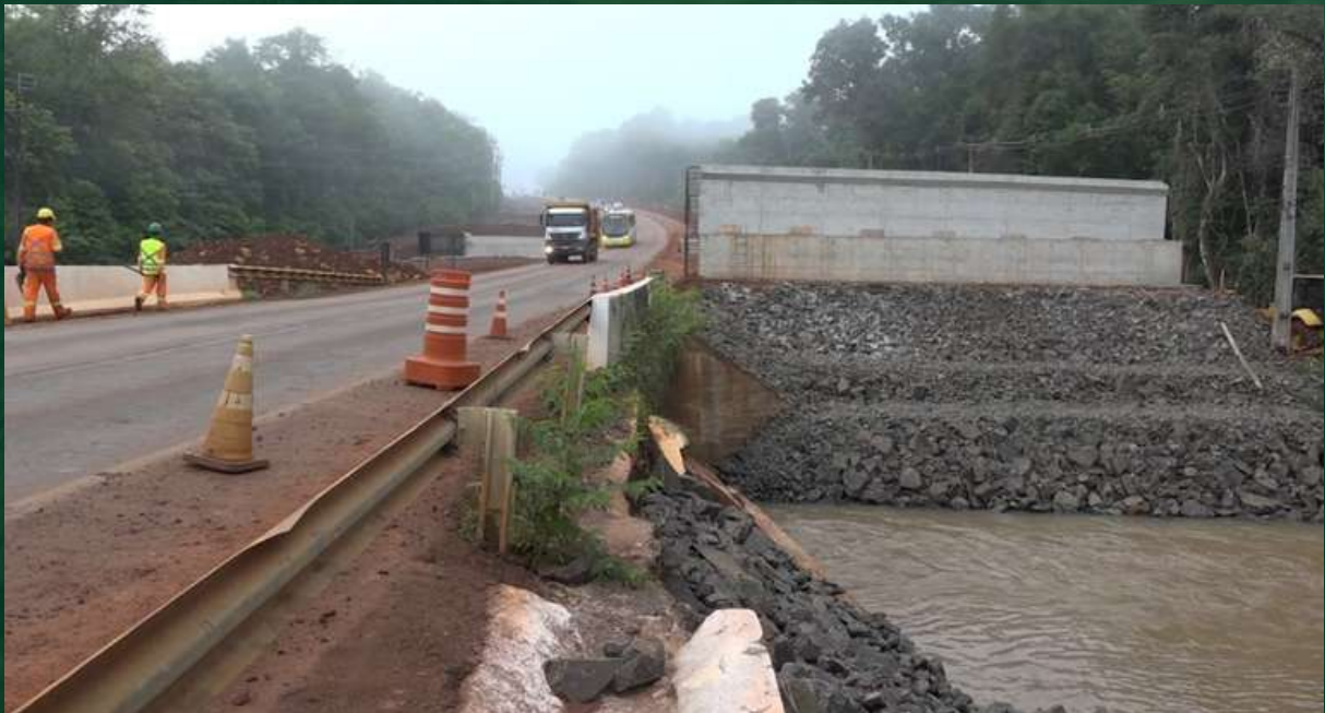
Figura 61 - Enrocamento (defensa) en la ribera del río Tamandúá (27/03/23)
