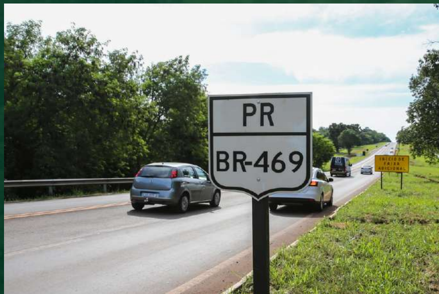
Figura 22 - BR-469 antes de la Obra de Duplicación
