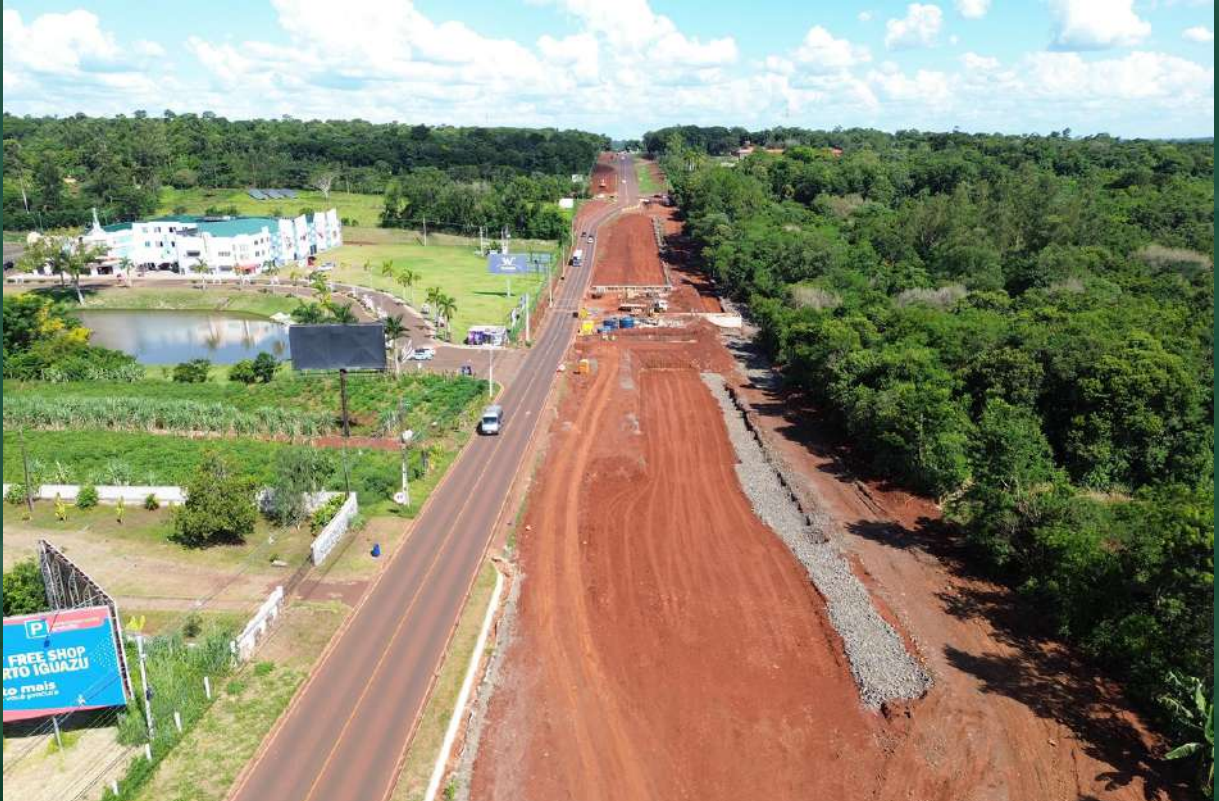
Figura 51 - Vista aérea del viaducto del km 7,6 (11/01/24).
