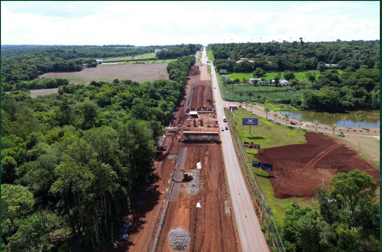
Figura 56 - Vista aérea del viaducto del km 7,6 (06/03/24).
