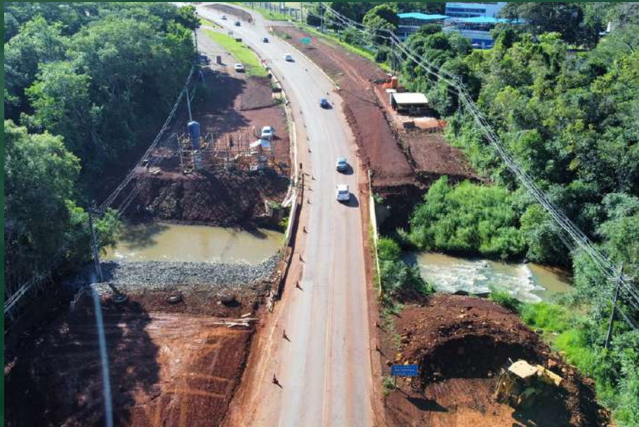
Figura 43 - Puente sobre el río Tamandúá (22/03/2023)
