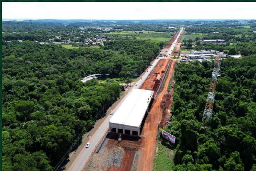
Figura 54 - Vista aérea del viaducto del km 2,2 (06/03/24).
