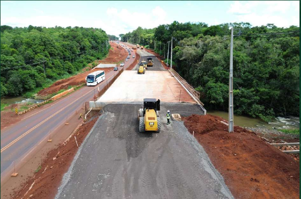
Figura 46 - Pavimentación del puente sobre el Río Tamandúá (11/01/24).
