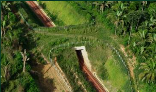
Figura 98 - Paso de Fauna 6
