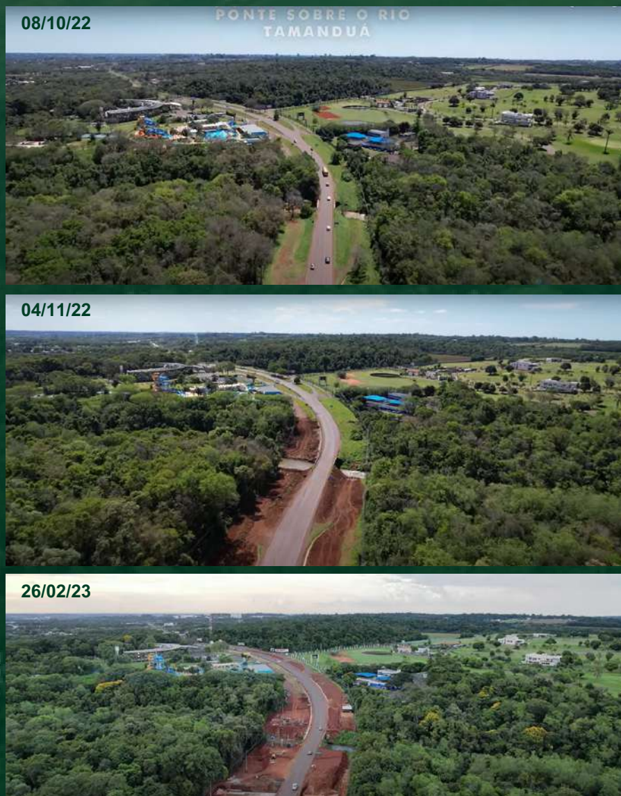
Figura 27 - Puente sobre el Río Tamanduá
