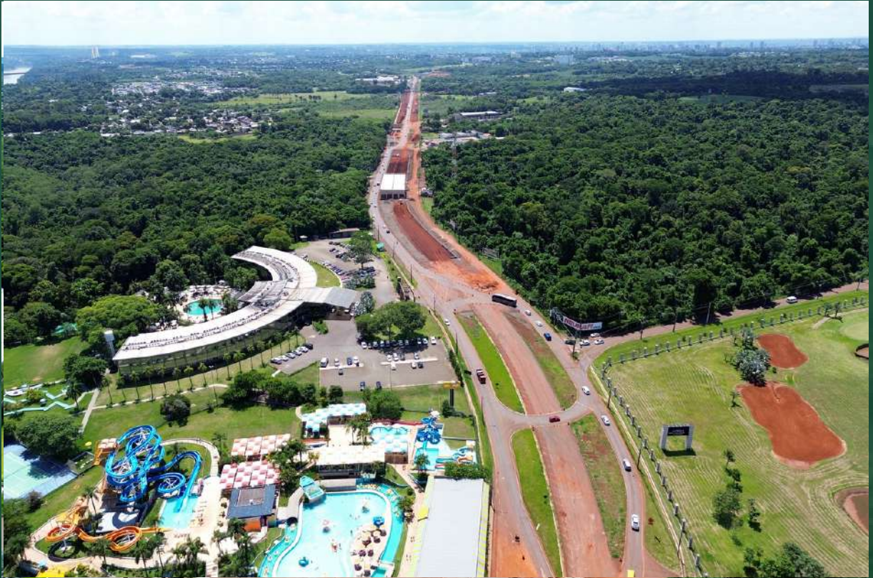
Figura 47 - Vista aérea del viaducto del km 2,2 (11/01/24).
