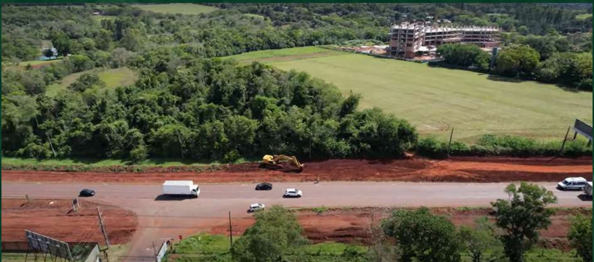
Figura 40 - Tramo de la BR-469 próximo al viaducto del km 3,9 (04/11/22).
