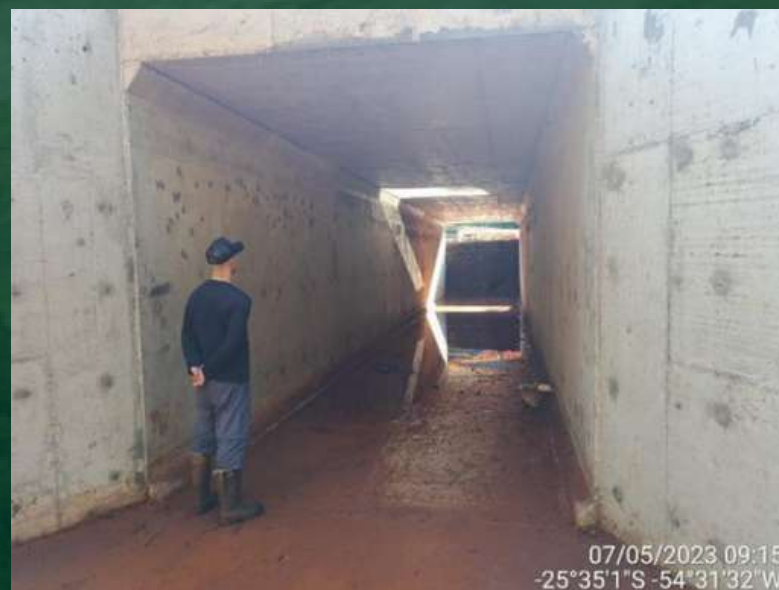
Figura 64 - Vista interior del Paso de Fauna subterráneo 01 (km 2+940)
