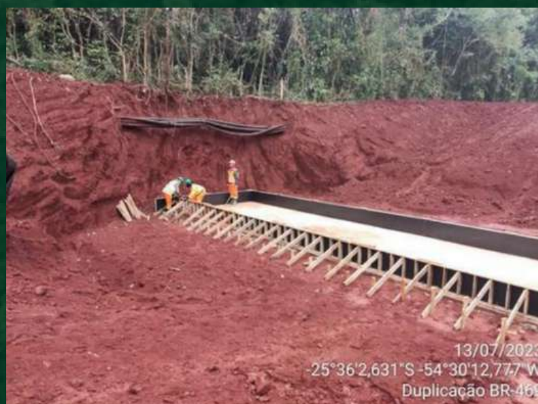
Figura 65 - Implantación del Paso de Fauna subterráneo 02 (km 5+854)
