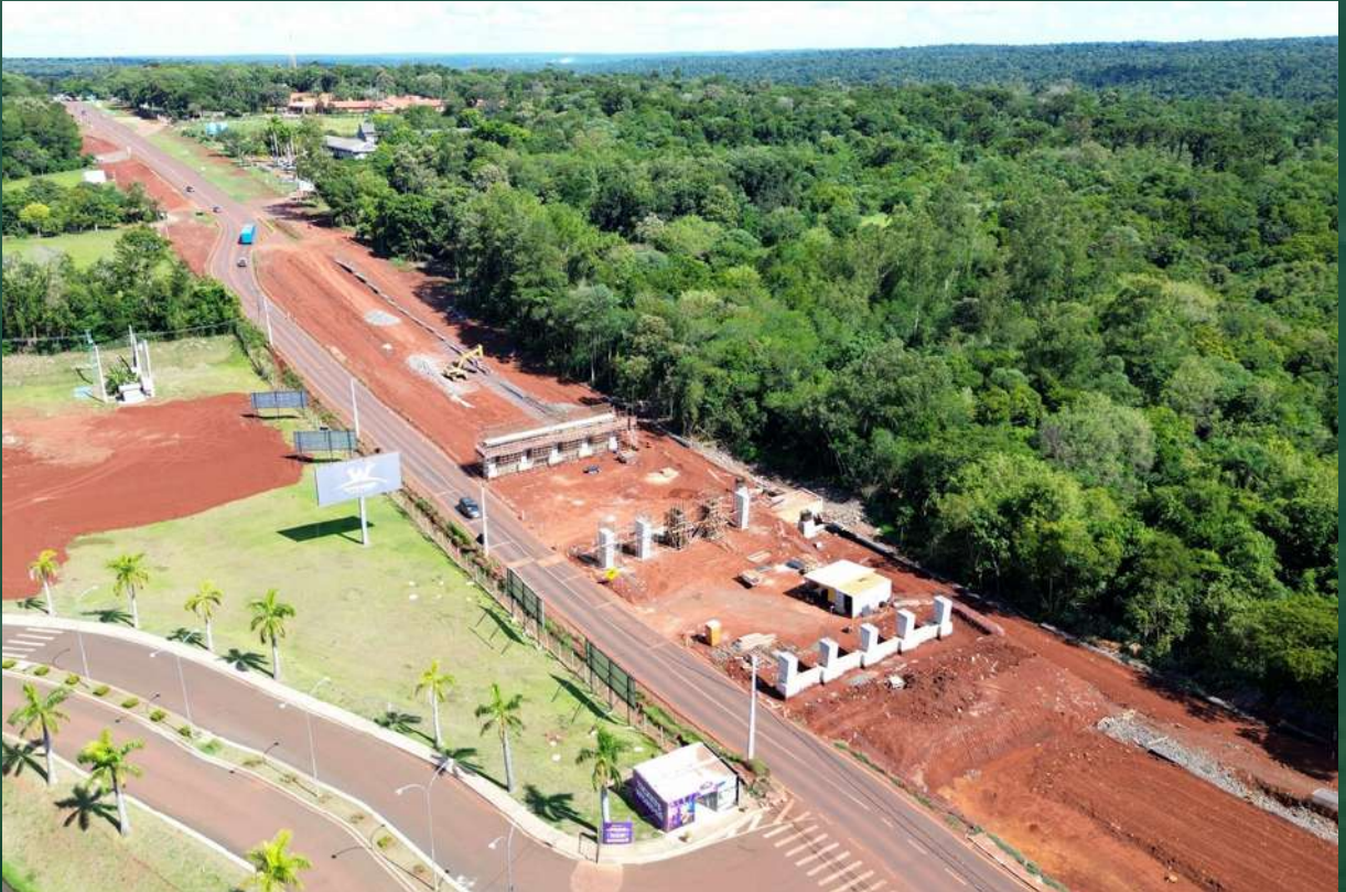
Figura 55 - Vista aérea del viaducto del km 7,6 en sentido PNI (06/03/24).
