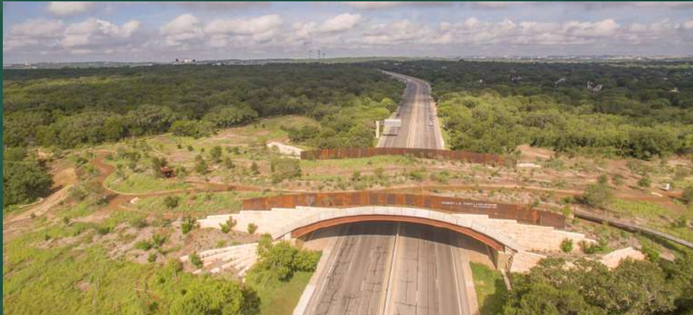
Figura 78 - Paso de fauna construido sobre la PA-1502 (EEUU)
