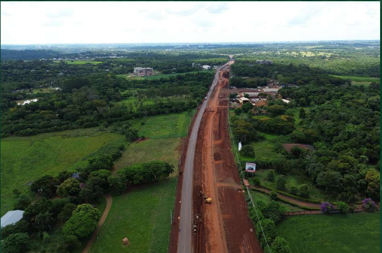
Figura 50 - Viaducto del km 3,9 y zona de almacenaje de elementos prefabricados (11/01/24).
