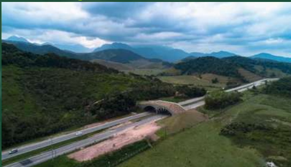
Figura 94 - Paso de Fauna 2
