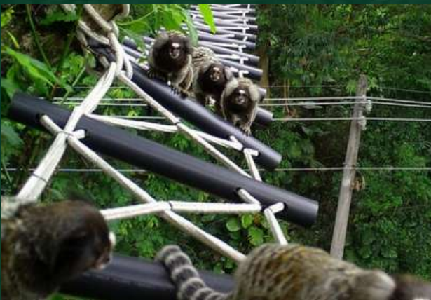
Figura 96 - Paso de Fauna 4
