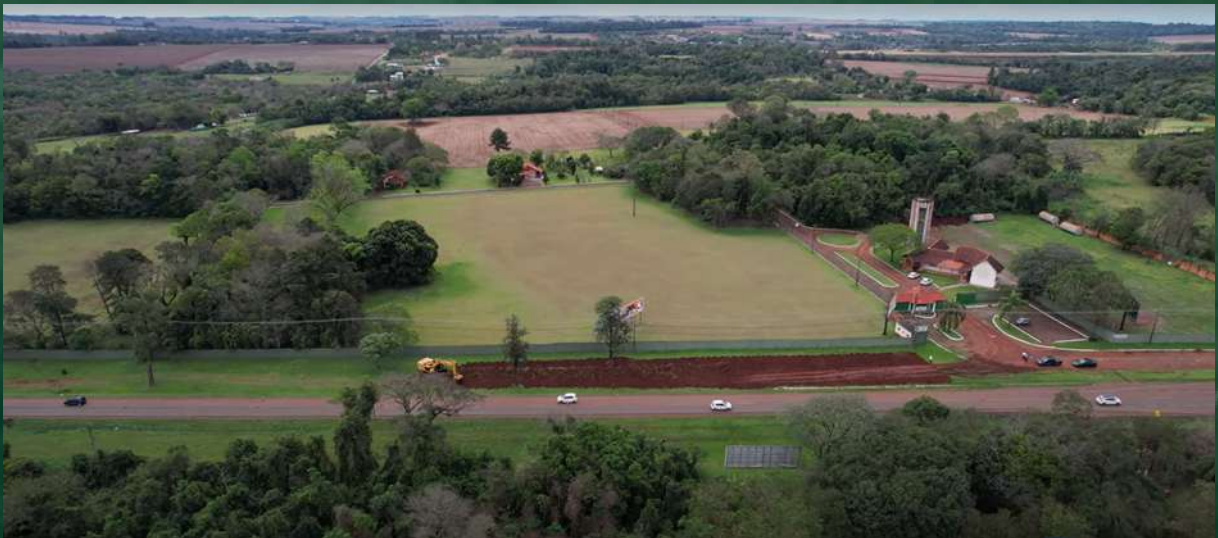
Figura 39 - Almacenaje de elementos prefabricados próxima al viaducto del km 3,9 (29/09/22).
