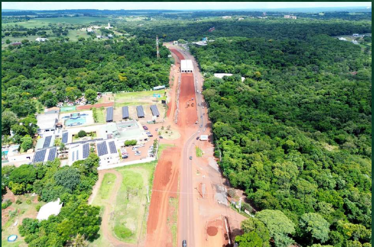
Figura 48 - Vista aérea del viaducto del km 2,2 en sentido PNI (11/01/24).
