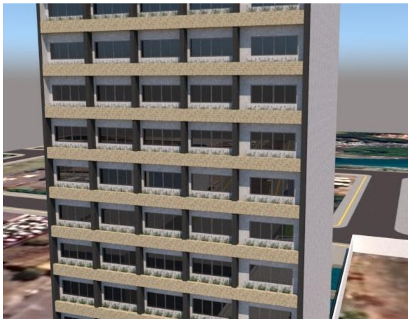
FACHADA DO PRÉDIO RESIDENCIAL. VEGETAÇÃO EM TODOS OS APARTAMENTOS
