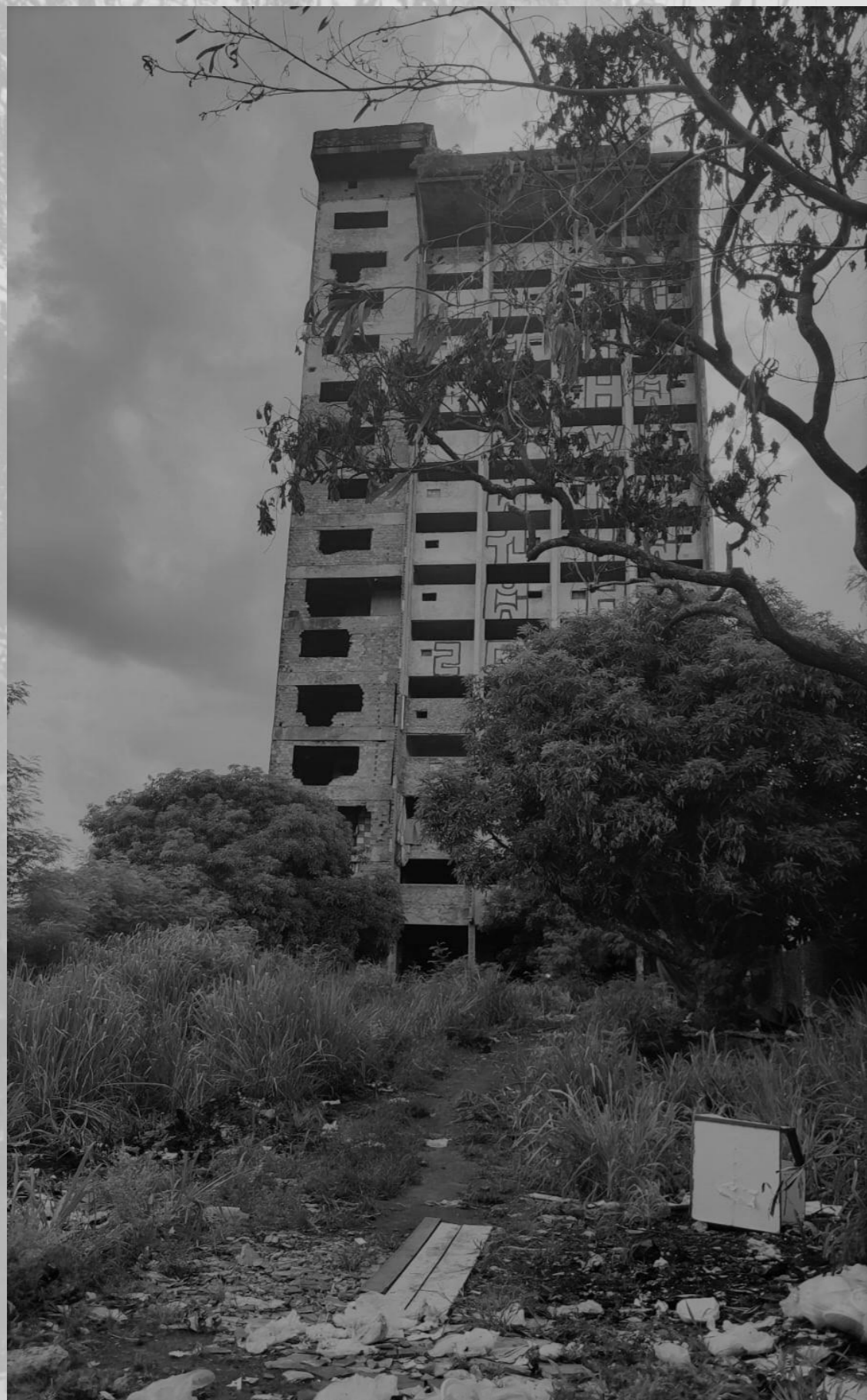
Figura 2: Prédio abandonado-acesso Fonte: Foto do autor (2022)
