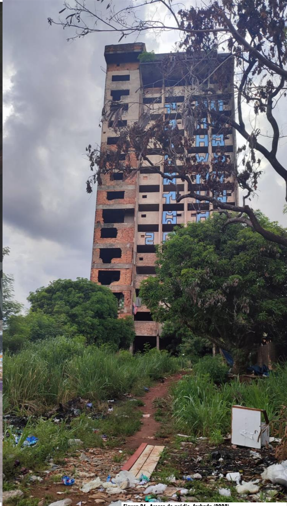
Figura 26: Acesso do prédio, fachada (2022) Fonte: Elaboração do autor (2022).
