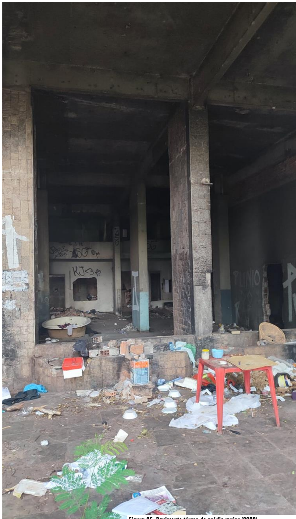
Figura 25: Pavimento térreo do prédio maior (2022) Fonte: Elaboração do autor (2022).
