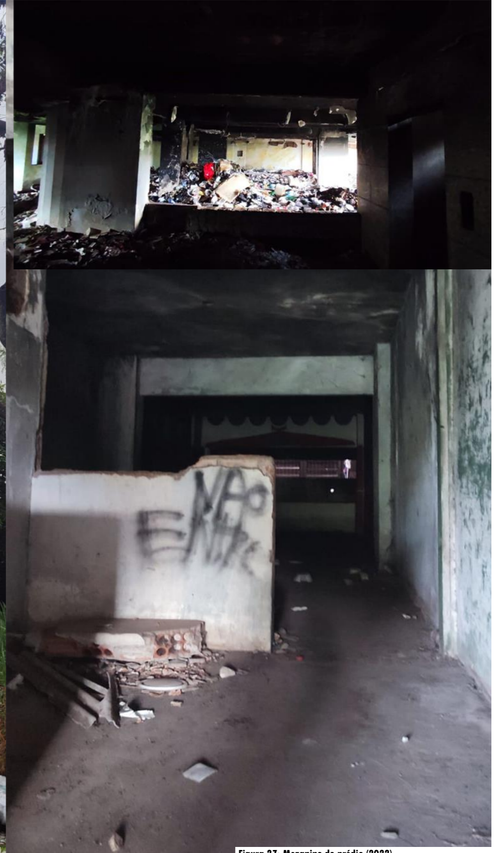
Figura 27: Mezanino do prédio (2022) Fonte: Elaboração do autor (2022).
