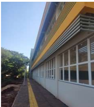
Figura 5.23. Vista externa parcial do Bloco 01
