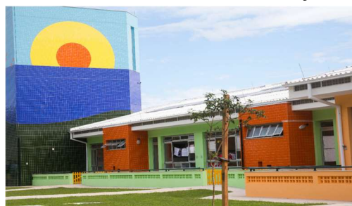
Figura 3.32. Elementos vazados instalados logo abaixo da cobertura auxiliam a circulação de ar
