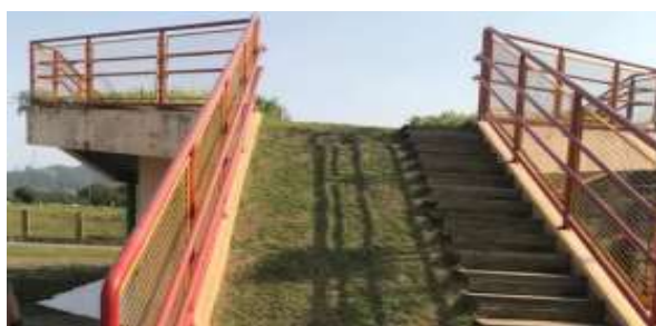
Figura 3.31. Área da creche com telhado verde
