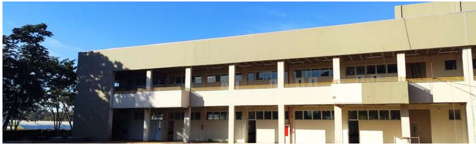
Figura 5.19. Vista sudeste da fachada frontal
