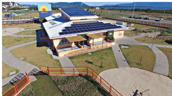
Figura 3.29. Creche Municipal Hassis. Placas fotovoltaicas instaladas na cobertura são utilizadas para geração da energia consumida
