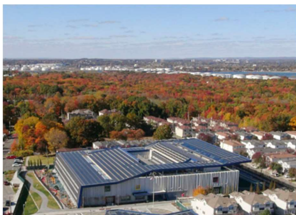
Figura 3.41. Vista aérea da Kathleen Grimm School . Painéis fotovoltaicos cobrem a cobertura e a fachada Sul
