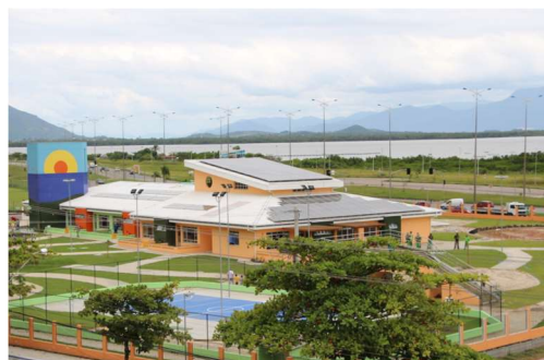
Figura 3.30. Vista externa da instituição
