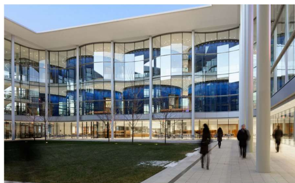
Figura 3.38. Vista do edifício a partir do pátio interno
