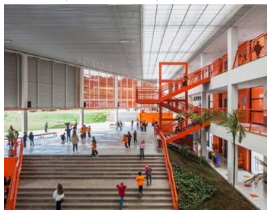
Figura 3.24. Fechamento do pátio interno por painel metálico perfurado
