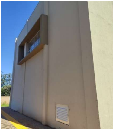
Figura 5.21. Vista sudoeste da fachada lateral
