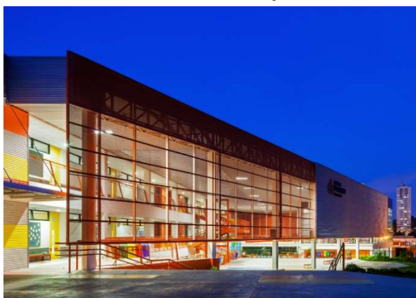
Figura 3.23. Painel metálico perfurado instalado na fachada da instituição
