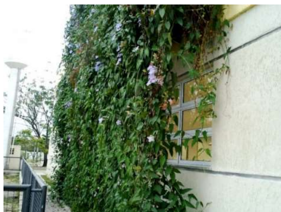
Figura 3.20. Jardim vertical instalado na fachada oeste
