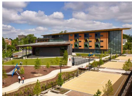
Figura 3.50. Simulações computacionais foram utilizadas na fase projetual para reduzir o consumo energético da edificação em operação
