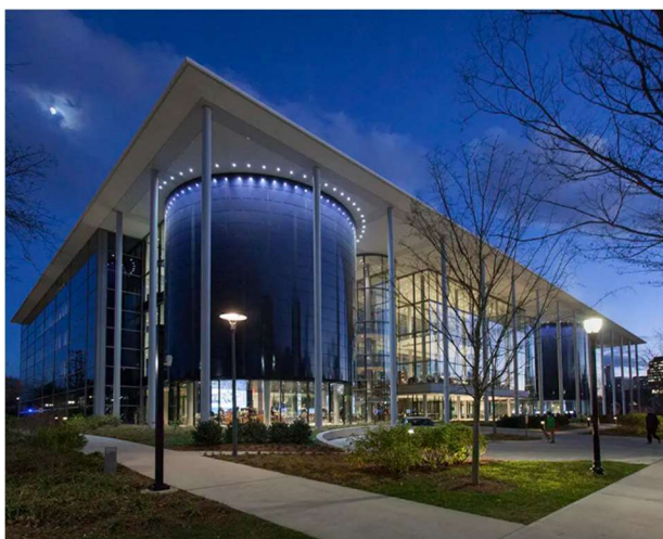
Figura 3.39. A cobertura se projeta para além do fechamento e ajuda a minimizar o ganho de calor solar
