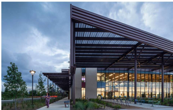
Figura 3.47. Varandas protegem a edificação da radiação solar excessiva
