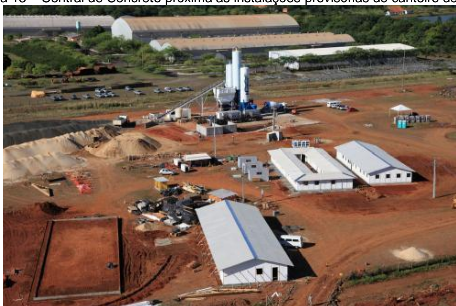
Figura 13 – Central de Concreto próxima as instalações provisórias do canteiro de obras
