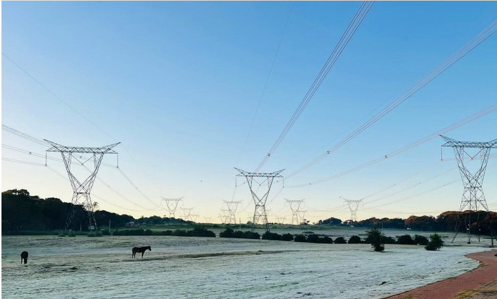
Fotografía 18. Caminos zona norte Vila C No.2 22
