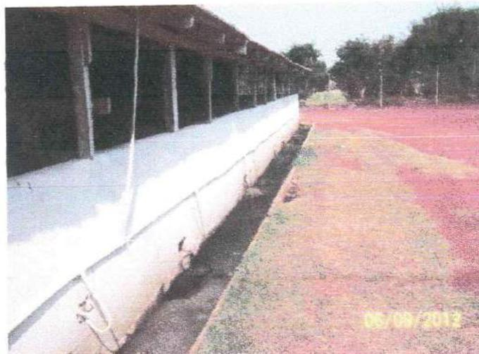
**Figura 32:** UT – beiral de telhado curto
