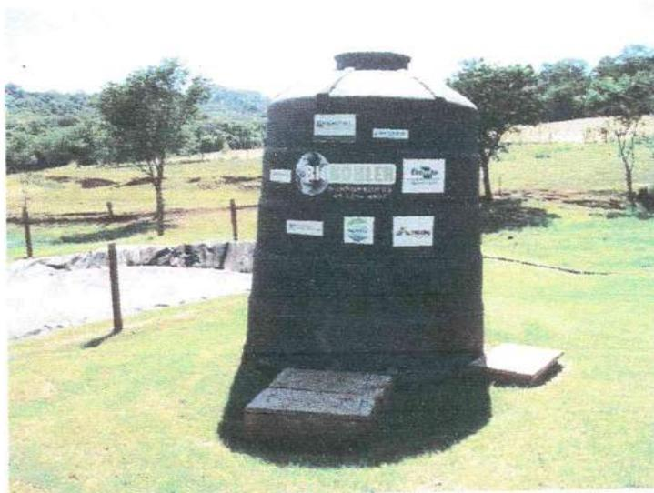
**Figura 7:** Biodigestor rural – versão UASB utilizado no projeto Condomínio Ajuricaba em Marechal Cândido Rondon/PR (visita alunos UNILA)
