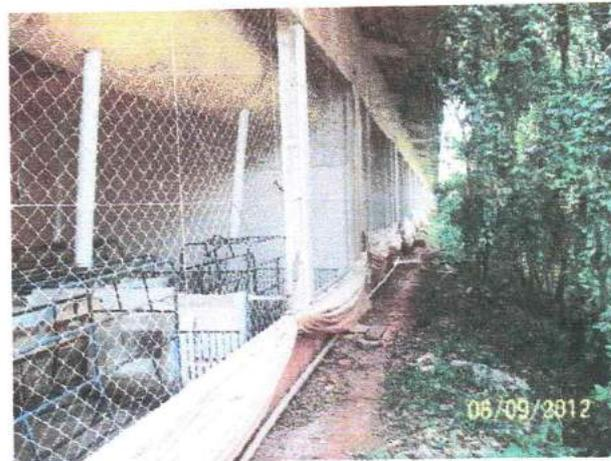
**Figura 30:** Maternidade - caixa de dejetos externa e beiral de telhado com bom tamanho
