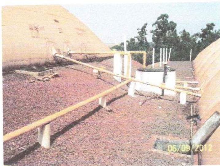
**Figura 34:** Caixa de passagem à 2ª célula do biodigestor sem mureta que impede a entrada de água da chuva e no fim do declive
