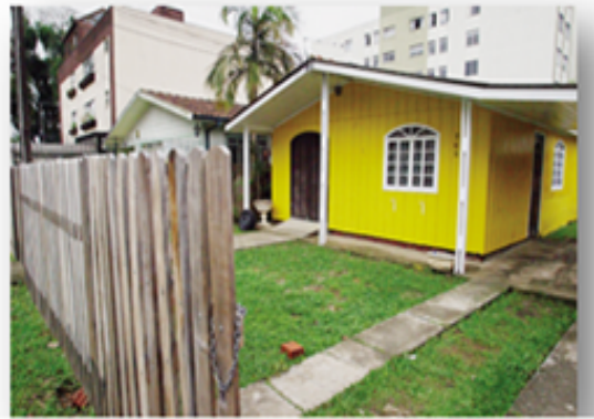
Casa de Madeira – Vila A
