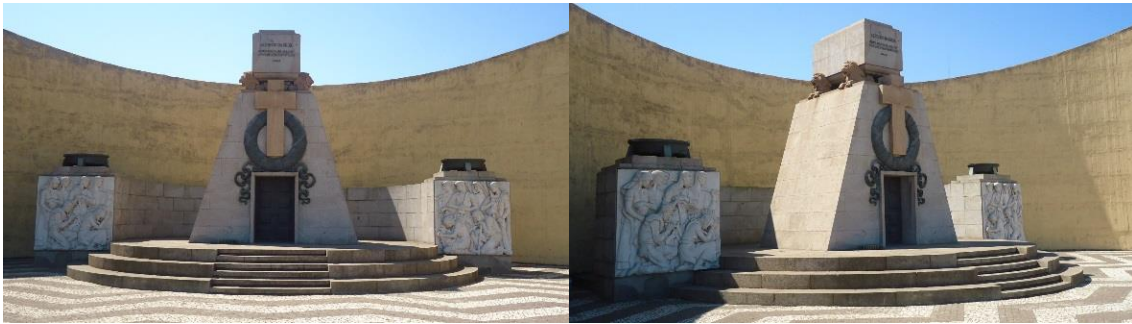
Figura 4: Vista frontal e lateral da mastaba do Mausoléu Alfredo da Silva, em Baía do Tejo/ Barreiro/PT
