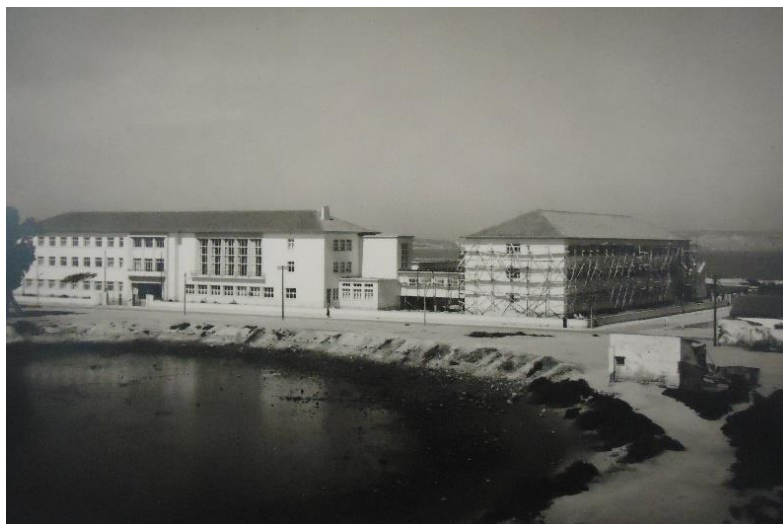
Figura 16: Reconstrução do edifício da EICAS (1956-1958)
