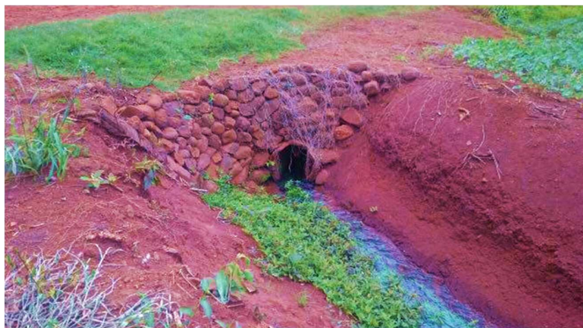
Figura 4.40 Bueiro existente no trecho
