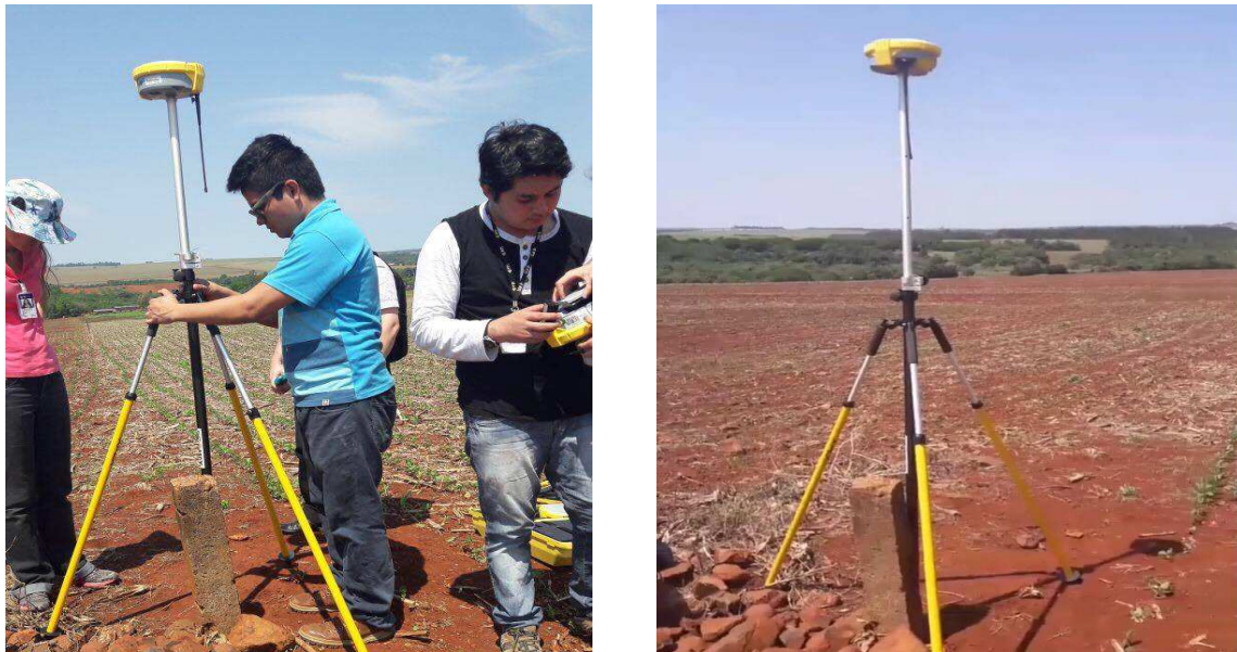
Figura 4.5 Instalação e configuração da Base RTK
