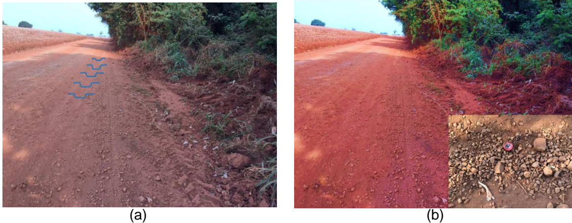
Figura 4.17 (a) Trilha de roda (b) Segregação de agregados
