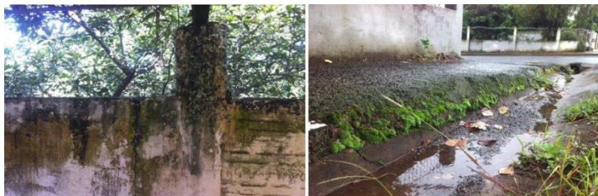
Figura 3.1. Patologias causadas por agentes biológicos.
